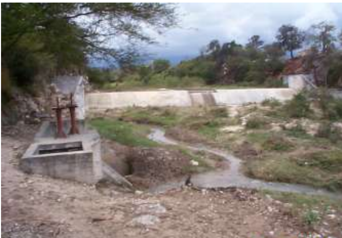
Le barrage international d'Anse à Pitres
